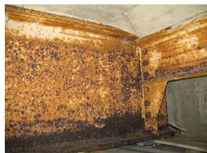
写真2 塗膜劣化
