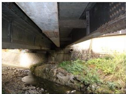
写真4 BK橋の桁下の様子
