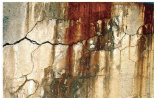
写真-1 ASR 劣化によるひび割れ
