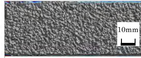
(a) 一般部の全面腐食
