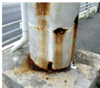
(b) 鋼製橋脚基部の破断
