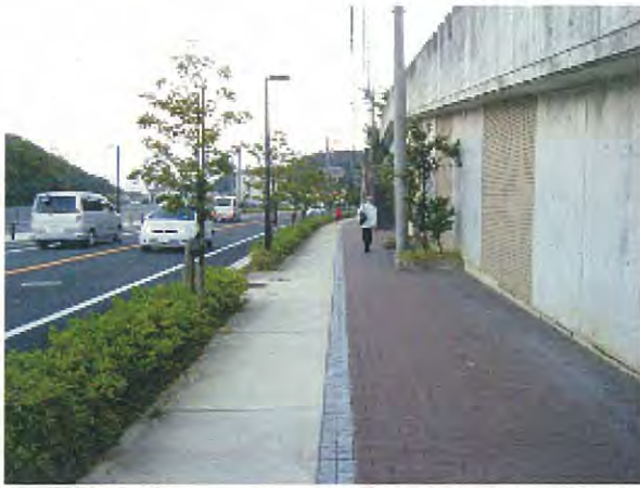
写真1 完成後の築上為石線歩道
