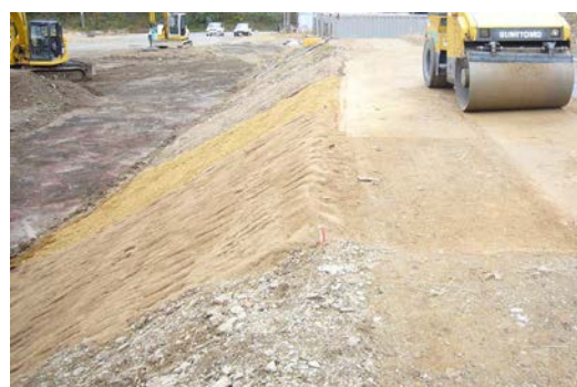
写真 1 転圧ローラによる盛土の施工状況
