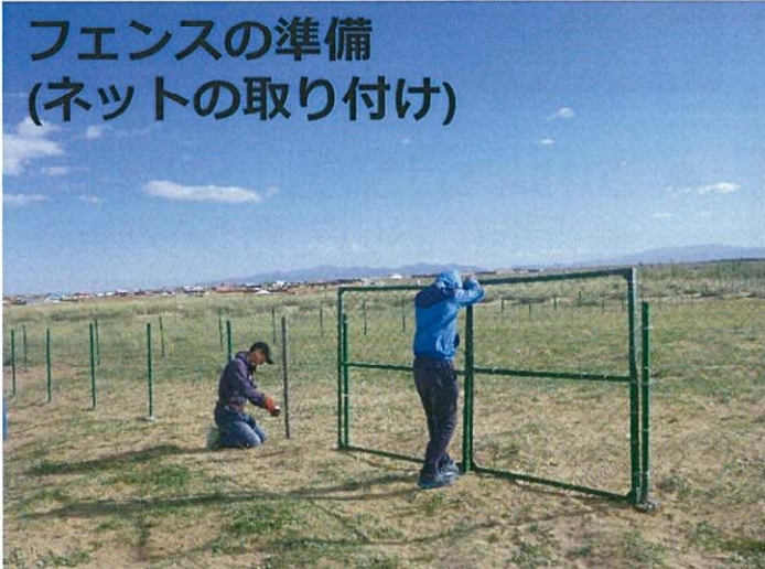
フェンス完成!!!
