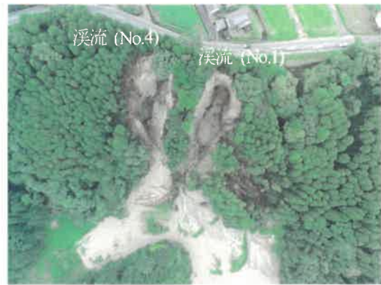
写真2 シラス斜面崩壊状況（曾於市大隅町） （鹿児島県土木部提供）
