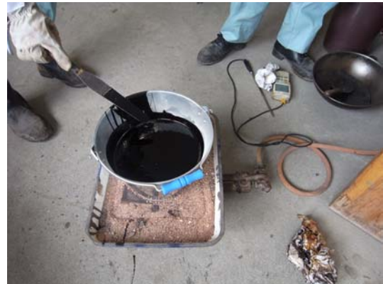
写真－4 CfFA 混合完了状況
