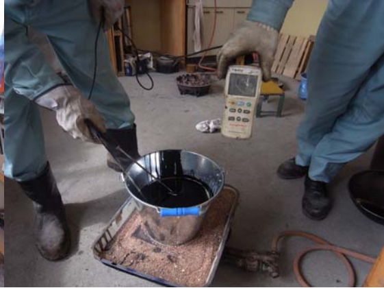
分量アスファルトの加熱 (120 度)
