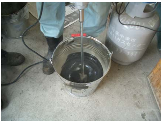
試験混合（攪拌機使用）
