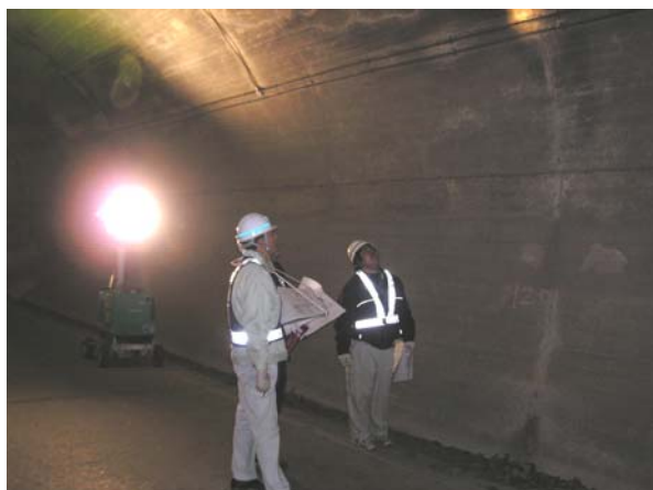
図.6 簡易法の点検状況
