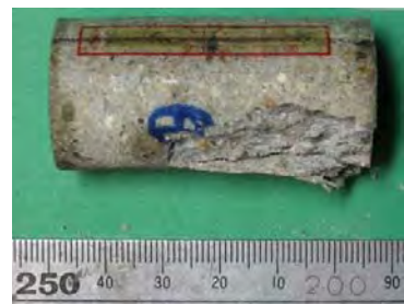
図-5 AM-S8 破壊後状況
