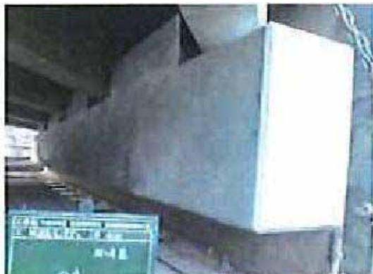
写真 3 RC 壁の設置例 (突起構造)
