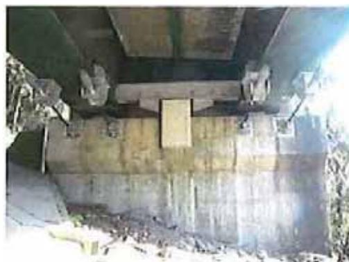
写真1 PCケーブルの設置例（上下部連結）
