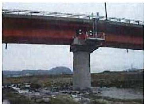
写真2 PCケーブルの設置例（桁連結）
