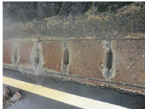
写真-1 温泉環境での硫酸劣化
