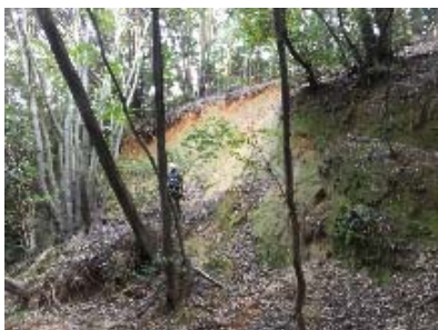
写真-1 崩壊地全景
