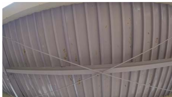
図 9 カメラによる撮影画像（渡り廊下下面）
