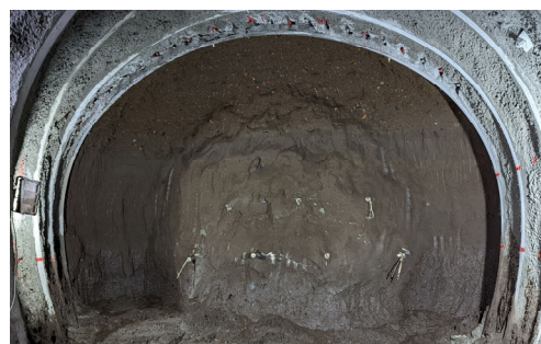
図-6 Aトンネルの切羽
