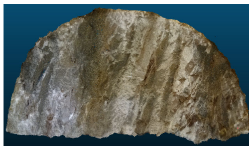
図-11 B トンネルの切羽
