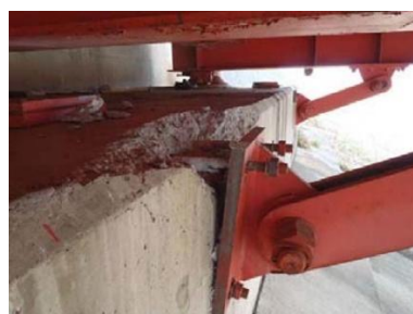
図 1 アンカーボルトの破壊が梁の中央スパンに発生する例
